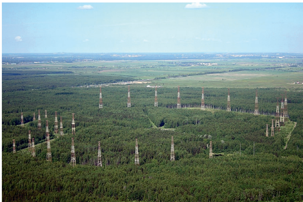
Рис. 1.11. Система радиобашен, выполненных из стальных труб, с синфазными горизонтальными диапазонными антеннами, размещенными между башнями разной высоты по определенной схеме (2008)
