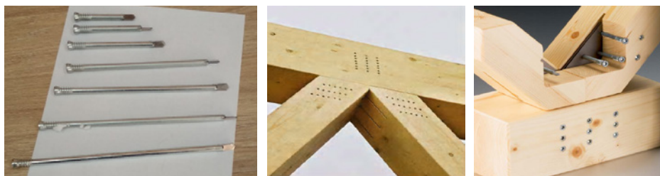
Рис. 4.5. Деревянное соединение с самонарезающими нагелями
