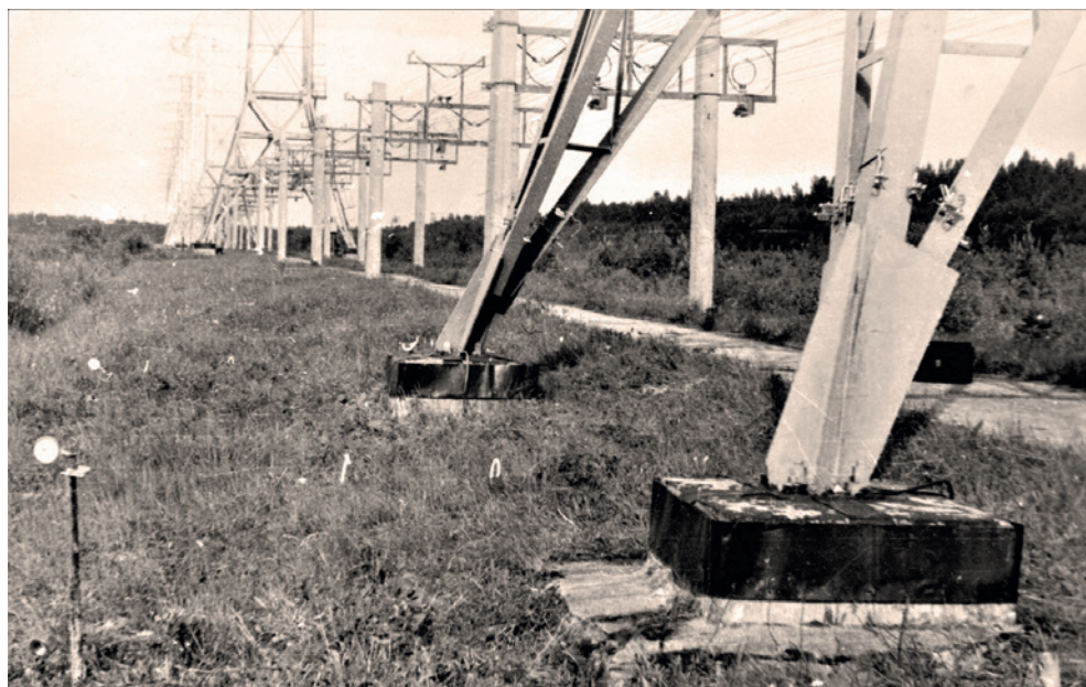
Рис. 1.13. Радиобашни системы «Заря» высотой 42,0 м; исследования влияния антенной подвески на отм. 41,0 м на возможность рихтовки радиобашни с перемещением верхней части (фото Н. А. Сенькина, 1979)
