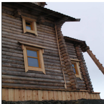
Рис. 5.39. Мерная рейка для отслеживания осадки сруба
