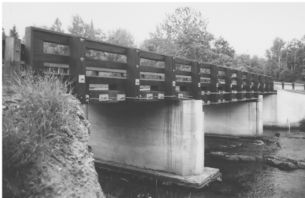
Рис. 3.1. Общий вид моста с предварительно напряженной многослойной древесиной. Мост Большого Эрика на р. Гурон (Big Eric's Bridge, Huron river) [87]
