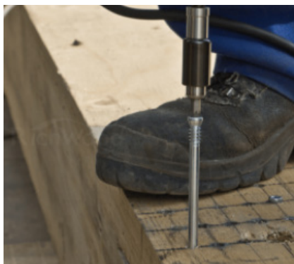
Завинчивание самонарезающих нагелей RothoBlaas в соединяемые LVL-блоки
