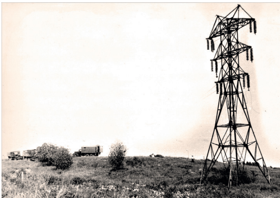
Рис. 1.15. Натурные испытания анкерно-угловой опоры ВЛ 110 кВ типа УМ102 с контролем усилий и перемещений фундаментов при участии автора в Москве, Орехово-Борисово (фото Н. А. Сенькина, 1980)
