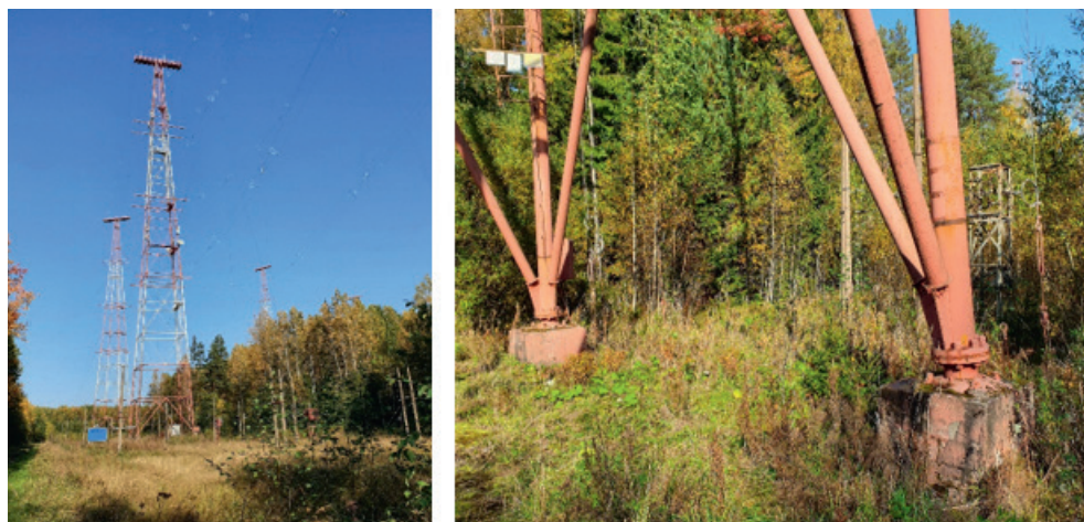
Рис. 1.12. Радиобашни СГД высотой 102,5 м (слева); радиобашня высотой 65 м, опорные узлы на фланцах и монолитные фундаменты (справа); межфланцевые прокладки установлены в 1975 г. (фото Н. А. Сенькина, 2020)
