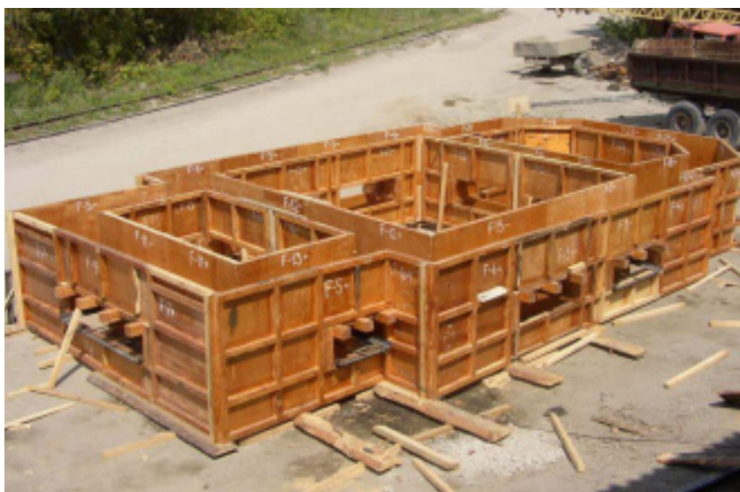
Рис. 5.35. Предварительная сборка щитов фанерной опалубки (без утеплителя) на площадке Барнаульского КЖБИ-2
