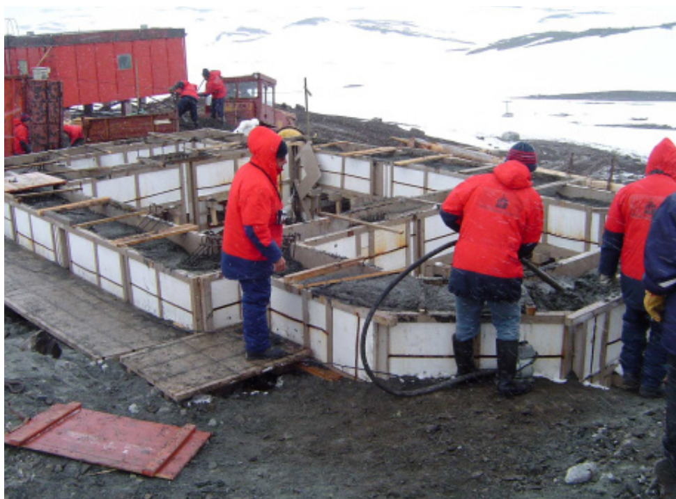
Рис. 5.36. Рабочий момент заливки и укладки бетона в утепленную опалубку с применением глубинных вибраторов в декабре 2003 г. на станции «Беллинсгаузен»
