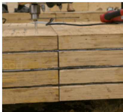
LVL-балки, соединенные при помощи пластин «ДекТай®» и самонарезающих нагелей RothoBlaas
