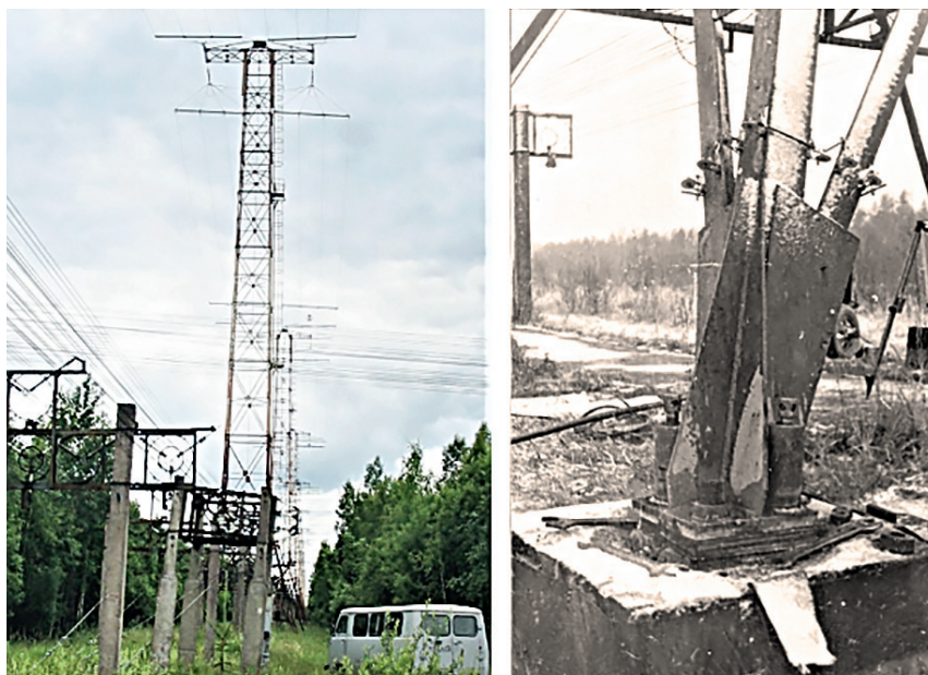
Рис. 1.14. Радиобашни системы «Заря» высотой 42,0 м; исследования влияния принудительного вертикального перемещения опорного узла на НДС радиобашни (фото Н. А. Сенькина, 1980)
