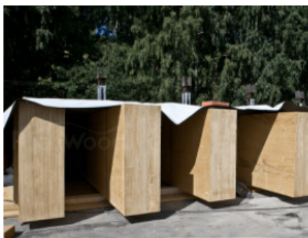
Поднятые на кровлю 7-метровые блоки
