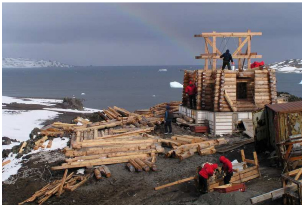
Рис. 5.37. Рабочий момент – возведение первых строительных лесов
