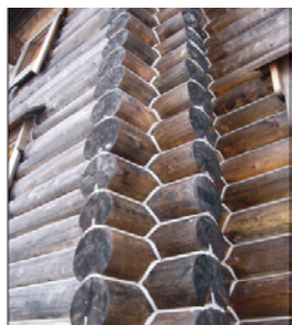
Рис. 5.41. Заделка наружных швов между венцами
