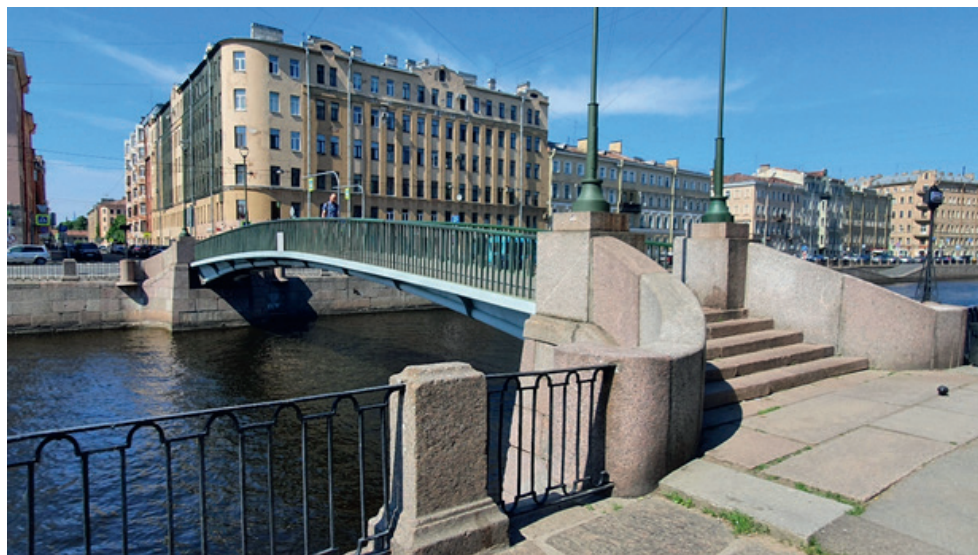
Рис. 1.6. Прекрасное произведение И. Н. Артемьевой – изящный алюминиевый цельносварной пешеходный мост Коломенский через канал Грибоедова общим пролетом 32,6 м (фото Н. А. Сенькина, 2021)
