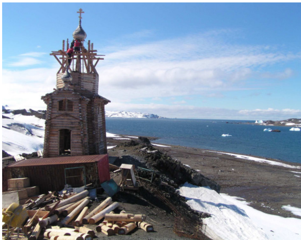
Рис. 5.38. Рабочий момент – подъем центральной главки
