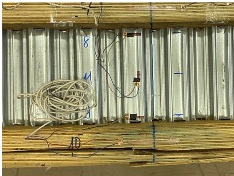
Рис. 9.17. Центральная часть разрушенной балки. Характерная трещина нижнего пояса
